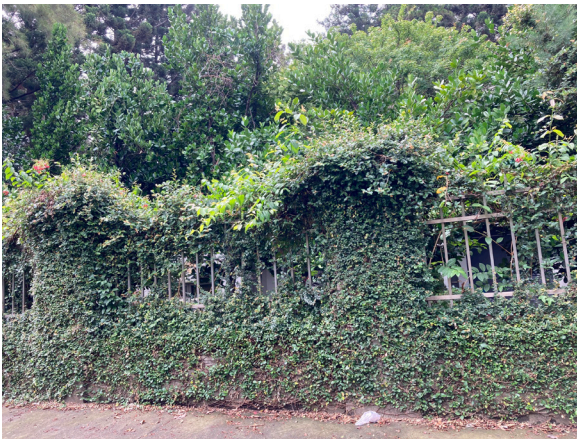
▲ 應用於實心柵欄鏤空牆 - 爬藤 (薜荔) 搭配懸垂植物 (使君子) 的綠圍籬。
