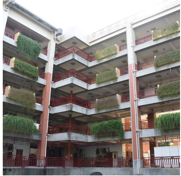
▲ 臺中市北屯區東光國小陽臺種植懸垂植物綠化建物。
